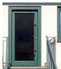
Die gleiche Tür nach Verkleidung mit Aluminiumrahmen in Wunschfarbe und mit neuen Beschlägen.
