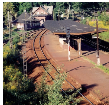
Der Lichtentanner Bahnhof mit Warthalle und dem denkmalgeschützten Bahnhofsgebäude
