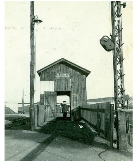
Der schienengleiche Bahnübergang um 1930
