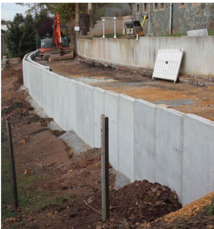
In der Heinrich-Heine-Straße in Lichtentanne wurde über das Förderprogramm LEADER des Freistaates Sachsen eine neue Stützmauer errichtet. Der Neubauabschnitt umfasst einen 50 Meter langen Böschungsbereich. Die neue Winkelstützwand stabilisiert den Fahrbahnrand an der Böschungsoberkante nachhaltig. [«]
