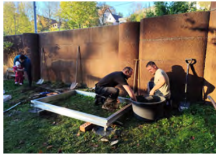
Vorarbeiten für unser Gewächshaus
